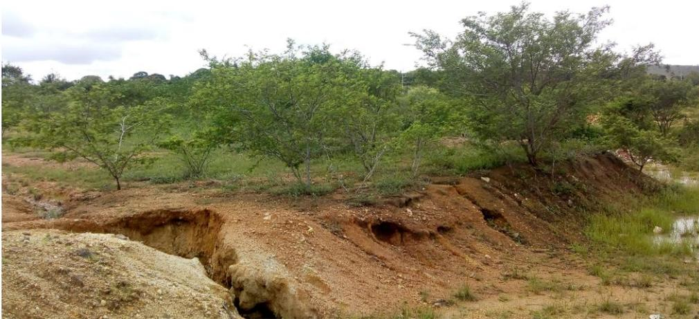
**Figura 33:** Detalhe do corte do terreno com processos erosivos decorrente da movimentação de terra. Foto: *Teia Serviços Ambientais*.
