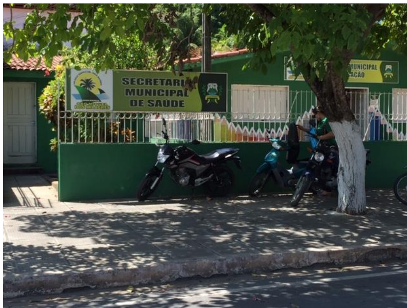
Fotografia 91 - Infraestrutura administrativa do município. Foto registrada em 04/11/2019. Acervo Encibra.
