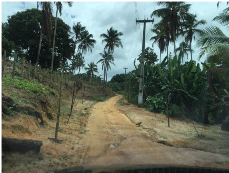
Fotografia 31 – Trecho final do acesso, em terra desprovida de dispositivos de drenagem. Culturas diversas às margens. Registro em 13/09/2020. Acervo Encibra.
