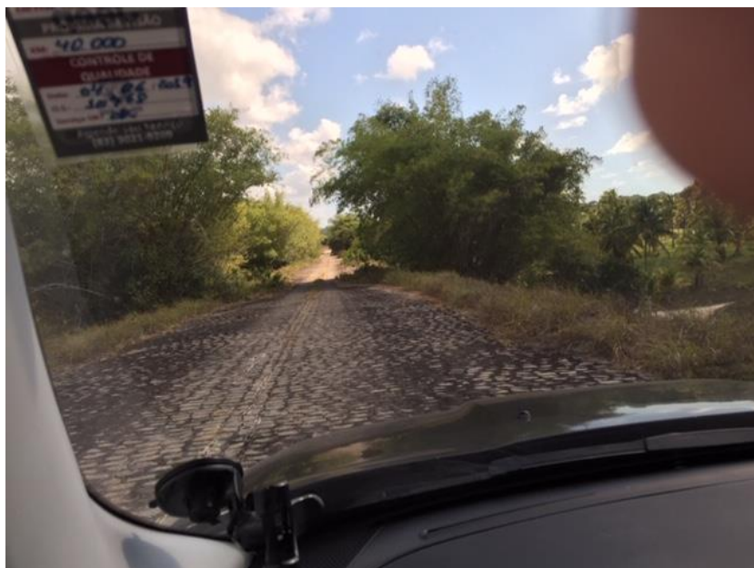
Fotografia 2 - Trecho em paralelepípedos para acesso à travessia do rio Camaragibe. Acervo Encibra. Foto registrada em 04/11/2019.
