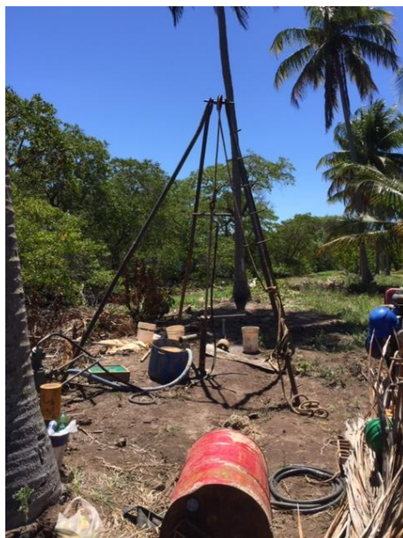
Fotografia 41 - Sondagem mista realizada na cabeceira da ponte sobre o rio Camaragibe. Clareira no Mangue. Lado direito. Acervo Encibra. Foto registrada em 16/01/2020.
