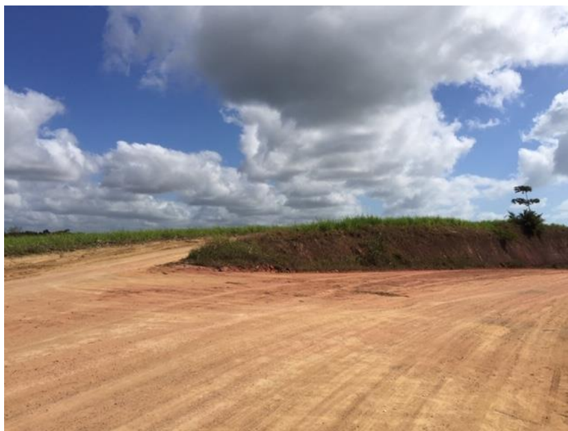
Fotografia 1 - Início do trecho rodoviário da AL-103 em Morros de Camaragibe. Acervo Encibra. Foto registrada em 04/11/2019.
