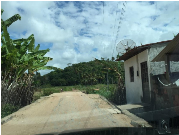
Fotografia 17 – Final do trecho em paralelepípedo. Ponte em concreto pré-existente. Registro em 13/09/2020. Acervo Encibra.
