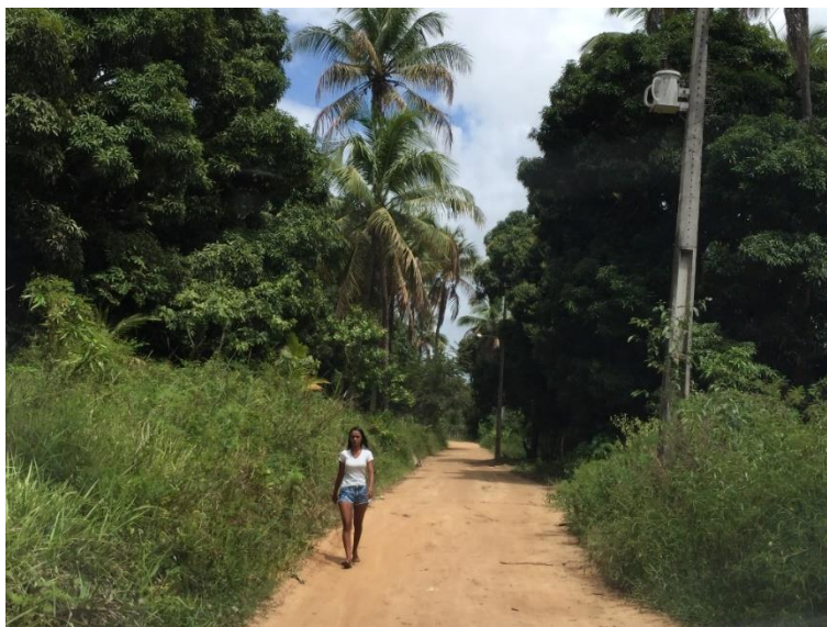
Fotografia 25 – Acesso se desenvolve por sobre estrada de terra pré-existente. Às margens da via existe a cultura de frutíferas. Registro em 13/09/2020. Acervo Encibra.
