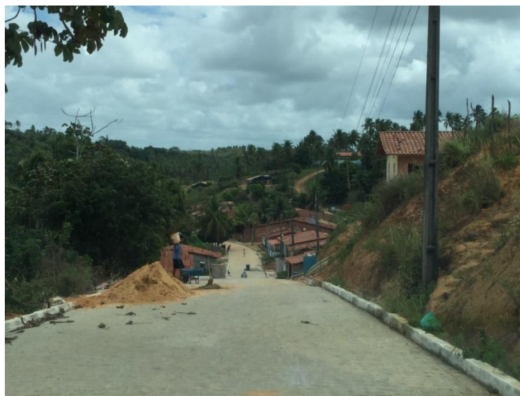
Fotografia 34 – Em Porto de Pedras. Acesso implantado pelo município. Paralelepípedos. Registro em 13/09/2020. Acervo Encibra.
